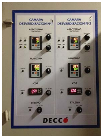
Fotografía 36. Panel de control en cámaras frigoríficas de desverdización de Decco.
