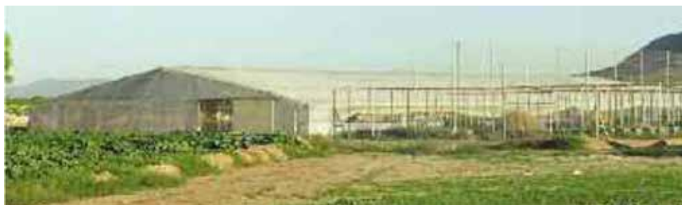
Invernadero tipo parral con estructura de palos metálicos en su interior. IMIDA (finca Torre Blanca, en Torre Pacheco).
