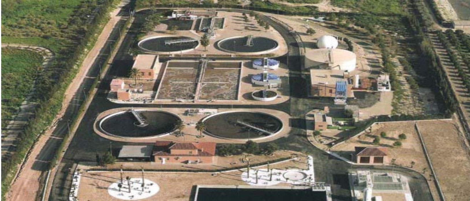
Vista aérea de la EDAR de Alcantarilla
