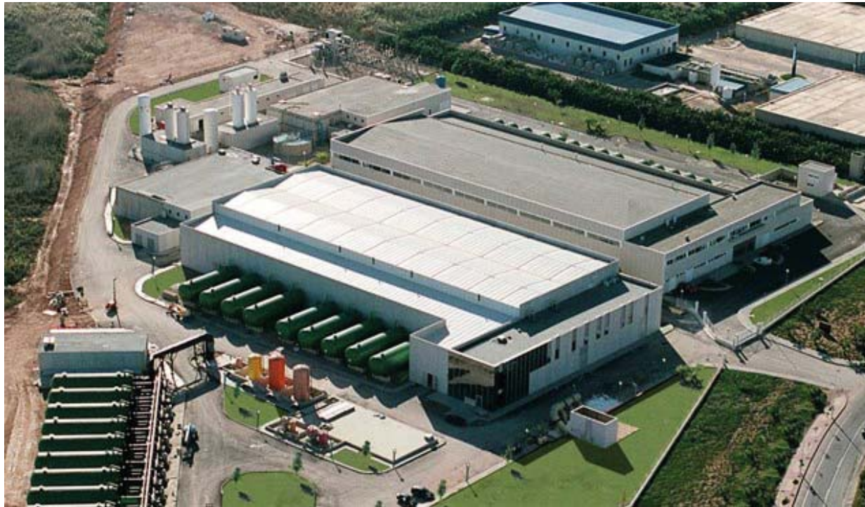
Vista aérea de la planta desalinizadora de San Pedro
